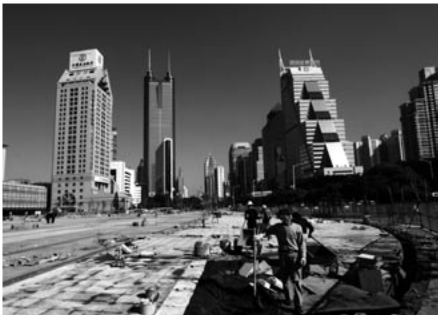
图4-2 蔡屋围金融中心区改造建设工程工地
