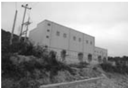
金海湾修建的污水处理站
