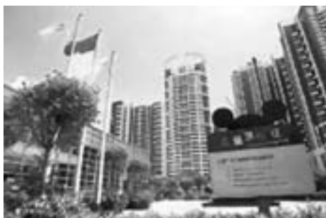
常规住宅物业外立面
