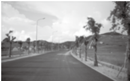
金海湾内部道路
