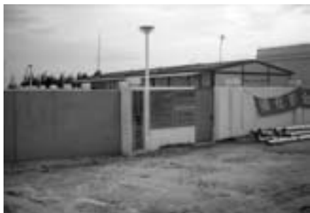
金海湾修建的临时气站
